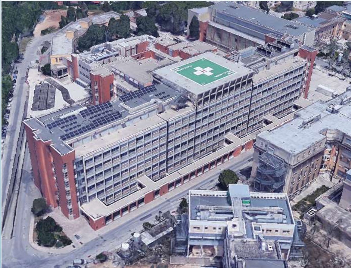
Impianto fotovoltaico del Padiglione Convitto Allievi
