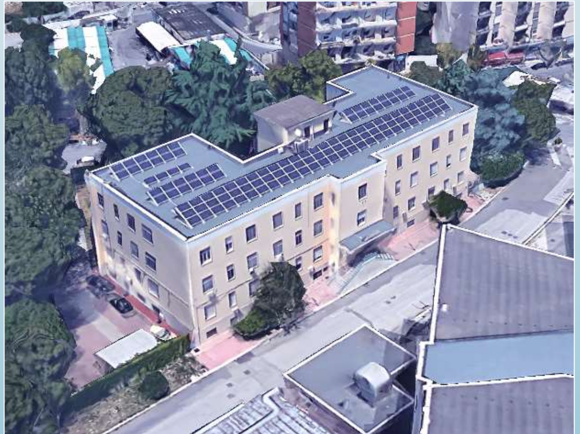
Impianto fotovoltaico del Padiglione Asclepios
